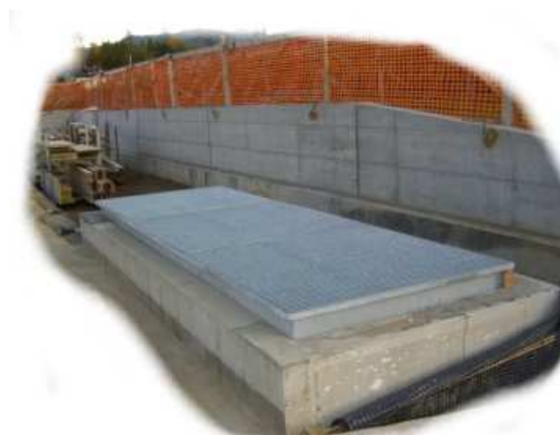
TELAIO CON GOCCIOLATOIO PIEGATO A MISURA
