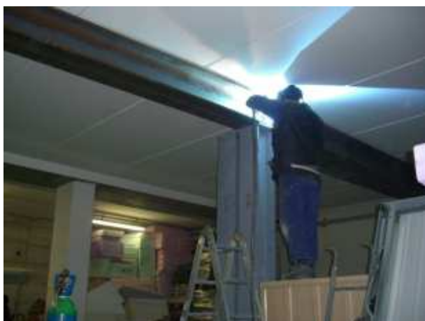
STRUTTURA IN ACCIAIO SALDATA FORMATA DA DOPPIE TRAVI HEB 340 MONTAGGIO AD INCASTRO SU STRUTTURA IN CEMENTO
