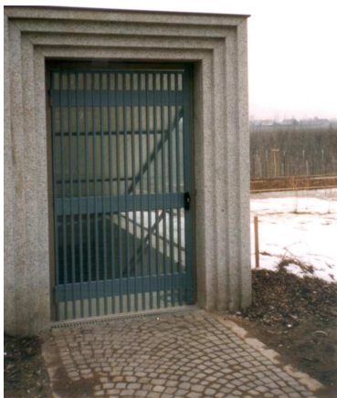
INGRESSO SECONDARIO GARAGE
