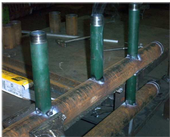
PARTICOLARE IN COSTRUZIONE DI COMPENSATORE IDRAULICO
