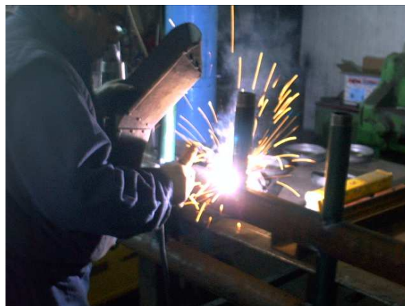
FASI DELLA SALDATURA DEGLI STACCHI
